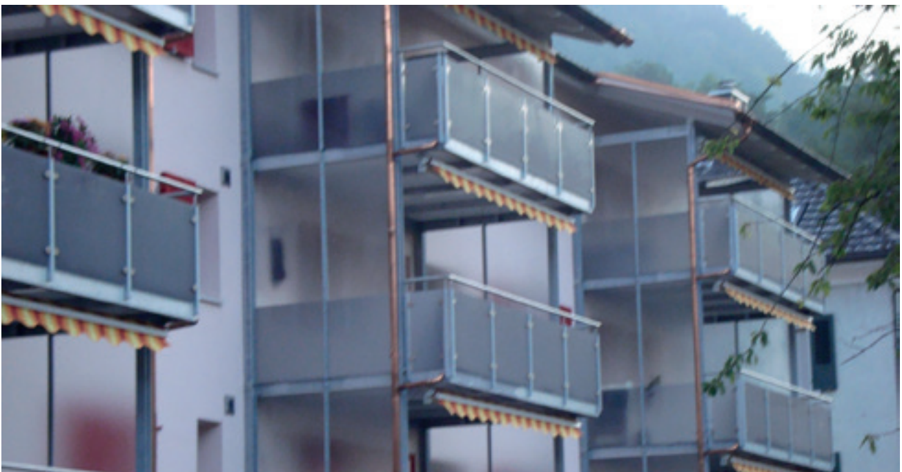
Kreis Metallbau, Projekt Hofjüngerstrasse Wattwil
