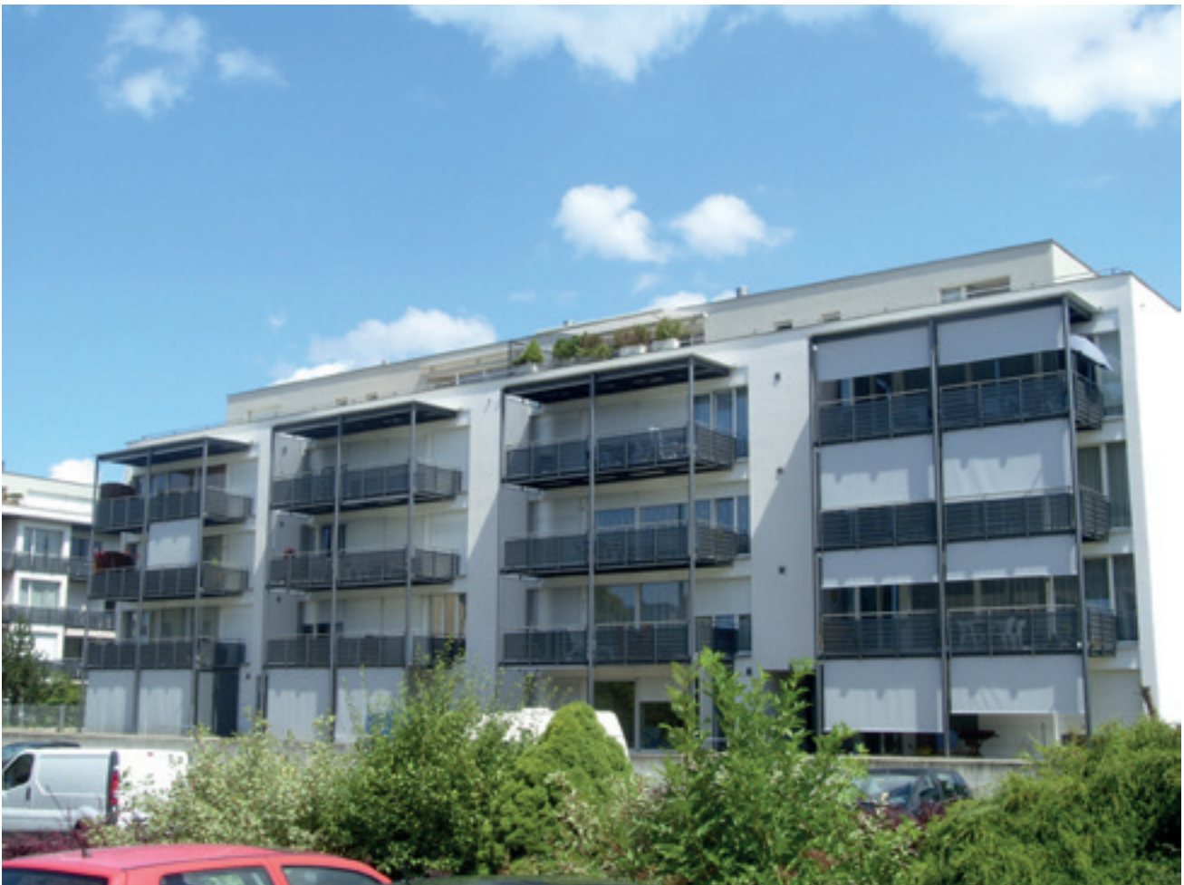
Progin SA, Immeuble Locatif La Berra, Bulle
