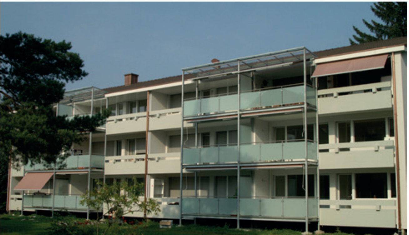
Suter Metallhandwerk, Projekt Bettenstrasse, Muttenz
