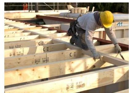
Deckenkonstruktionen für erhöhte Belastungen wurden bauseits aus STEICO LVL gefertigt.
