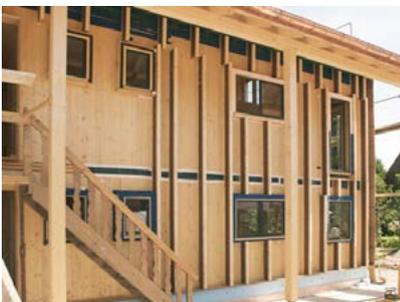
Schaffung einer Dämmebene auf der Massivholzwand durch STEICO<sup>wall</sup> als schubsteife Unterkonstruktion.
