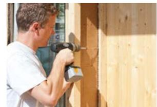
Die werkseitig eingebrachte Stegdämmung sorgt für den gewohnten Rechteckquerschnitt. Somit können die Gefache mit dem Mattendämmstoff STEICOflex effizient gedämmt werden.
