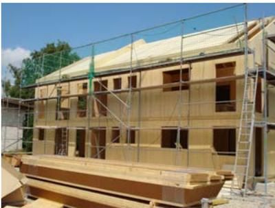
Fertig abgebundene STEICO<sup>joist</sup> Dachsparren warten auf die Montage am Dach.
