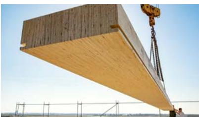
Decken- und Dachelemente aus STEICO <sup>GLVL R</sup> Furnierschichtholz
