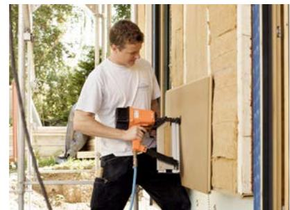
Ausdämmung der Wandgefache mit STEICO<sup>flex</sup>. Gefachabschluss mit STEICO<sup>universal</sup> als zweite wasserführende Schicht hinter der Lärchenholzschalung.
