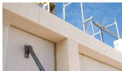
Primärtragwerk aus STEICO <sup>GLVL R</sup> Unterzügen und Stützen
