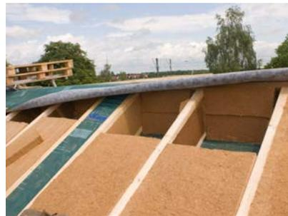
Blick in die Dämmebene der Dachkonstruktion. Vorgeämmte STEICO<sup>joist</sup> Stegträger mit STEICO<sup>flex</sup> Dämm-Matten.
