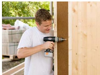
Befestigung von STEICO<sup>wall</sup> Stegträgern mittels Holzschrauben durch den hinteren Gurt.
