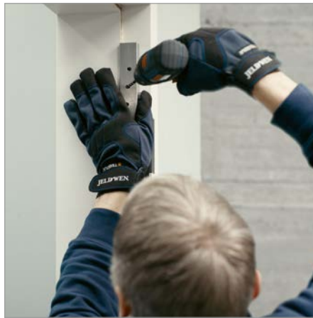
Schrägverschraubung mit Bohrschablone
