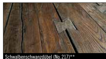
Schwalbenschwanzdübel (No. 217)**
