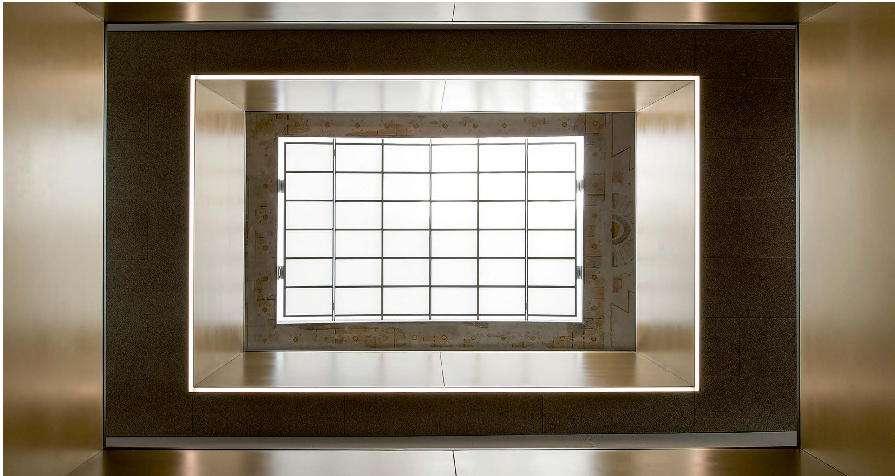
Die neuen Räume von Schweiz Tourismus in der alten Stadthalle Zürich Verwendetes Produkt: Akustik-Gewebe WeavePerf®-uno weiss bedruckt, eingespannt in Alu-Profil Bild: ©Amt für Städtebau Zürich, Juliet Haller
