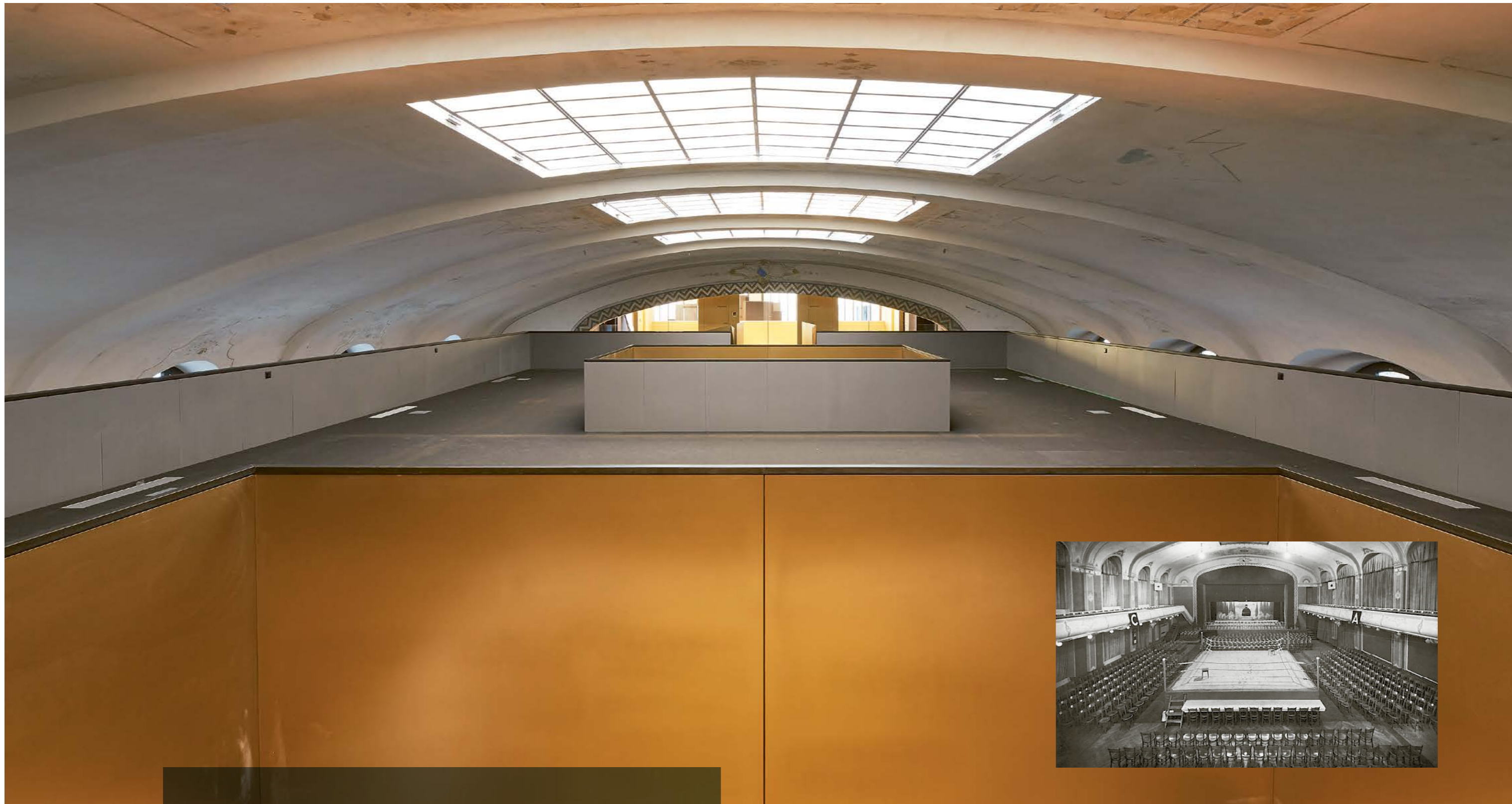
Die neuen Räume von Schweiz Tourismus in der alten Stadthalle Zürich Verwendetes Produkt: Akustik-Gewebe WeavePerf®-uno weiss bedruckt als Deckenelement bei den Oberlichtern und SonoPerf® aus Stahl an den Brüstungen der Galerie Bild: ©Heinz Unger, Zürich
