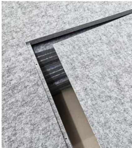
Wichtig ist, dass das Sägeblatt frisch geschärft ist. Empfohlen wird ein Blatt mit Hohlzahnschliff oder eines für furnierte Platten.
