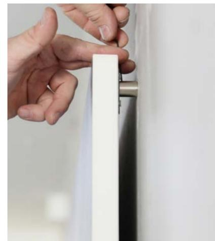
Die Halterung wird auf die Rückseite der Platte geschraubt, die Hülse an die Wand gebohrt.
